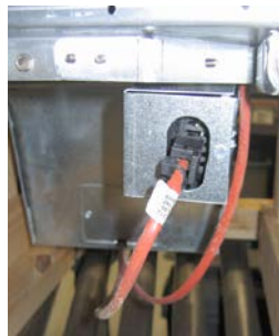
الشكل 6: قم بتركيب الموصلات البيضاء ذات المسمارين وقم بتوصيل الموصل الأسود مع صندوق الخدمة كما هو موضح. * لاحظ أنه قد تختلف وضعية الموصل الأسود عن الشكل الواضح في الصورة.
